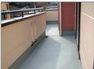
一般的な屋上防水の他、戸建住宅バルコニーなどにも多く採用されています。露出仕上げて防水層上の歩行が可能であるため、歩行用のベランダ、バルコニーなどに適用できます。また、樹脂の硬化速度が速いため、すべての工程を1日で完了させることが可能で、小面積でも効率的に施工を行うことができます。【シート系材料との複合法も行われています。】
