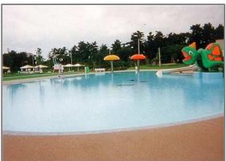
FRP は以前から浴槽や漁船など船体、浄化槽など水廻りの機器に採用されていたように、耐水性・耐食性に優れた材料です。FRP のこのような特徴を活かして、プール・水槽などの水廻りの防水の他、下水道、雑排水槽、薬品槽など、耐食性を求められる用途にも幅広く採用されています。
