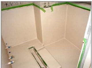
浴室は屋内での施工になるため、特に改修工事においては従来の FRP 防水に比べ臭気の少ない環境対応型 FRP 防水材料を使用する環境対応型 FRP 防水工法が採用されています。この工法は従来の FRP 防水工法と比較し、施工時の VOC 放散量が大幅に低減されるという特徴がありますが、同時に施工時の安全性向上も図れることから UR・都市機構の浴室改修工事に採用されています。
