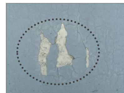
以上ご紹介した防水層の不具合事例は、下地の状況や施工時の外的条件等により発生するケースが多くなっています。また、建物の構造や下地に適した防水層の仕様選択が不適切であった場合でも発生しやすくなりますので、不具合発生防止のためには、適切な下地処理・防水仕様を選択・施工管理が特に重要です。
