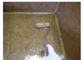
写真2 FRP層成形中
